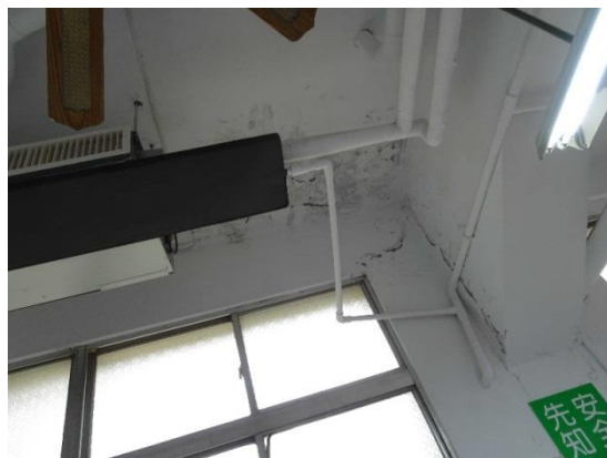
機電整合實習工場-第一實習大樓 1 樓
